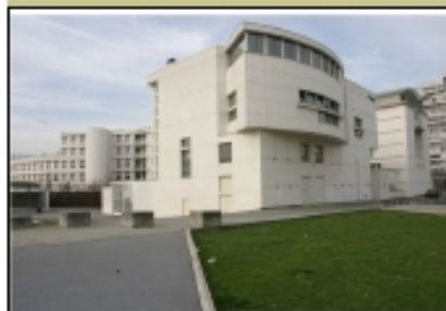
Façade de l'École
